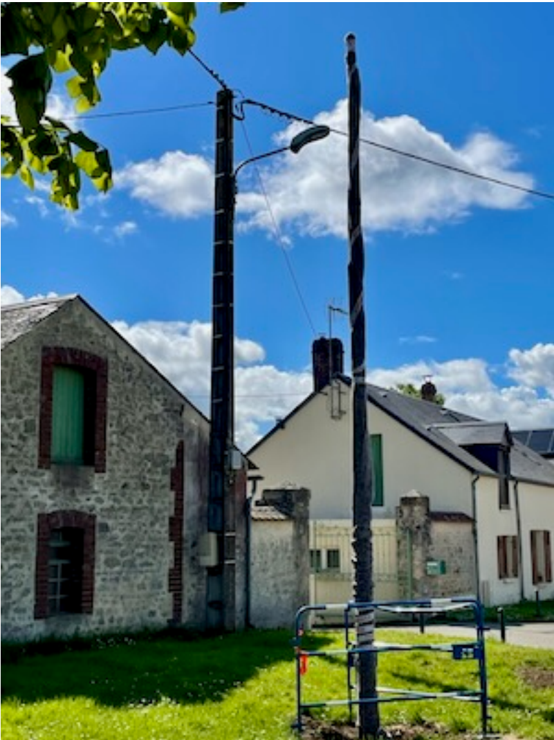
Le nouvel éclairage public est en train de se mettre en place en remplacement de l'ancien.
