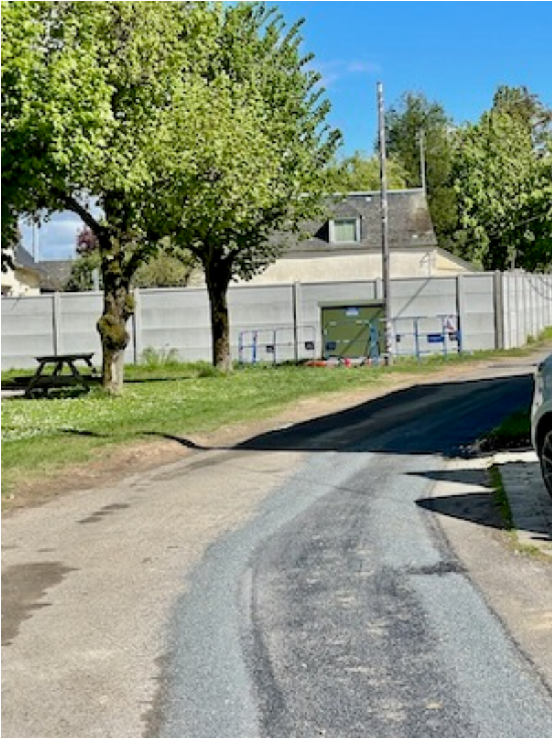
Les tranchées sont refermées.
