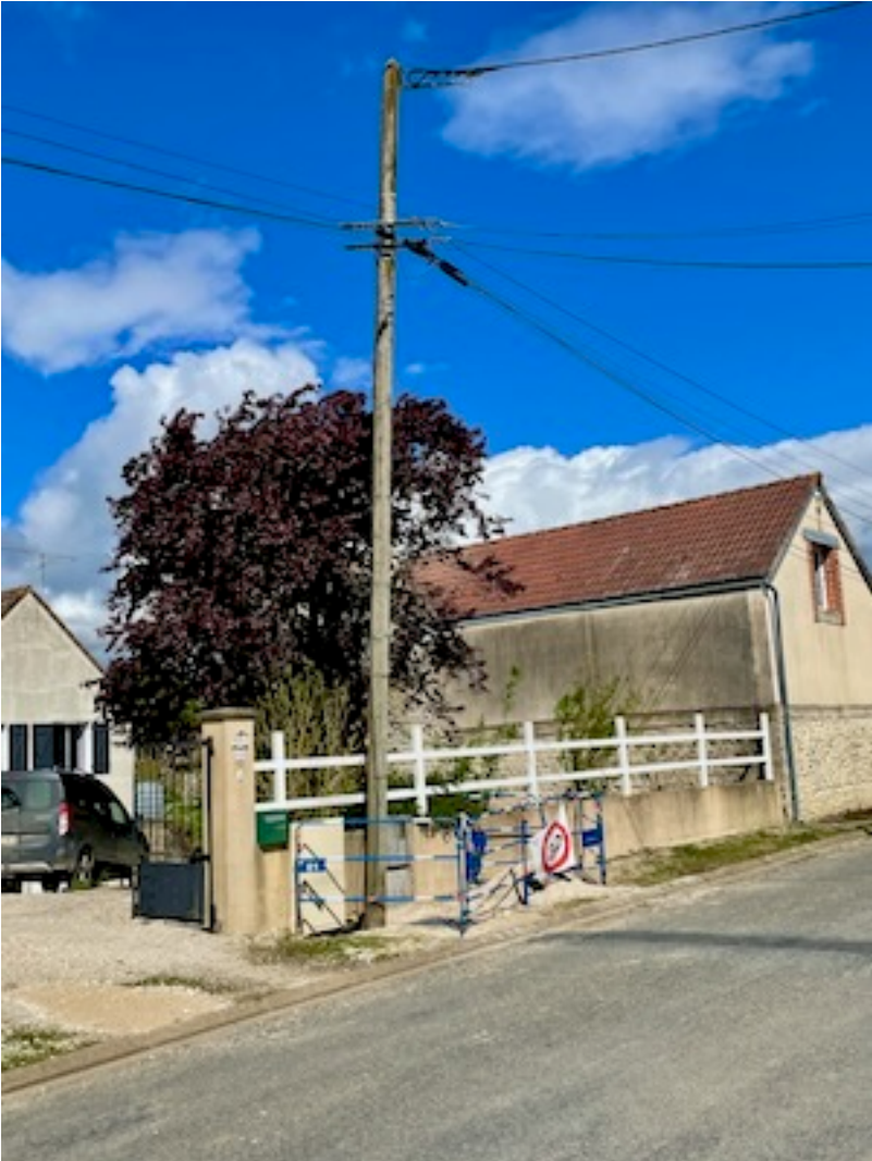
Le branchement de la fibre en souterrain et le retrait des poteaux seront effectués avant l'hiver.
