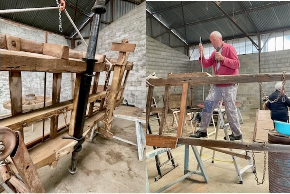
Renforcement de la structure.
