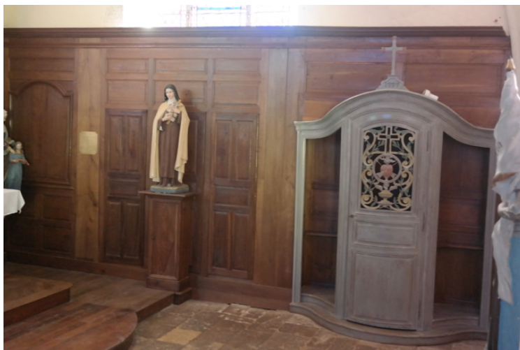
Boiserie et Confessionnal après les travaux.
