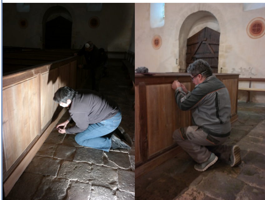
Décapage en conservation de l'ensemble. Un travail fastidieux, avec notamment le décapage à sec....
